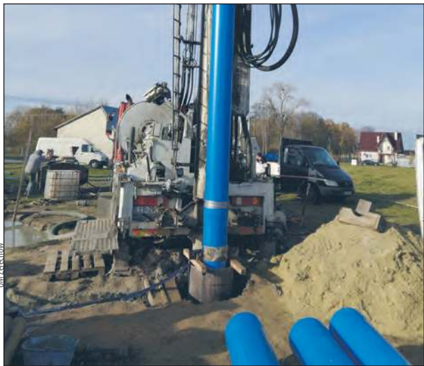
W chwili obecnej inwestycja koncentruje się na pracach budowlanych
