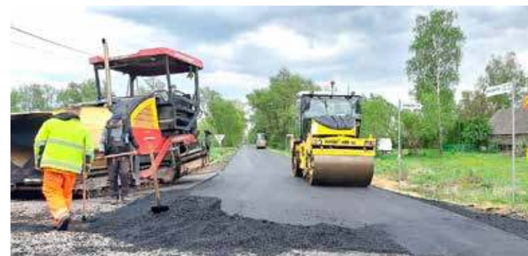
Jedna z przebudowywanych dróg
