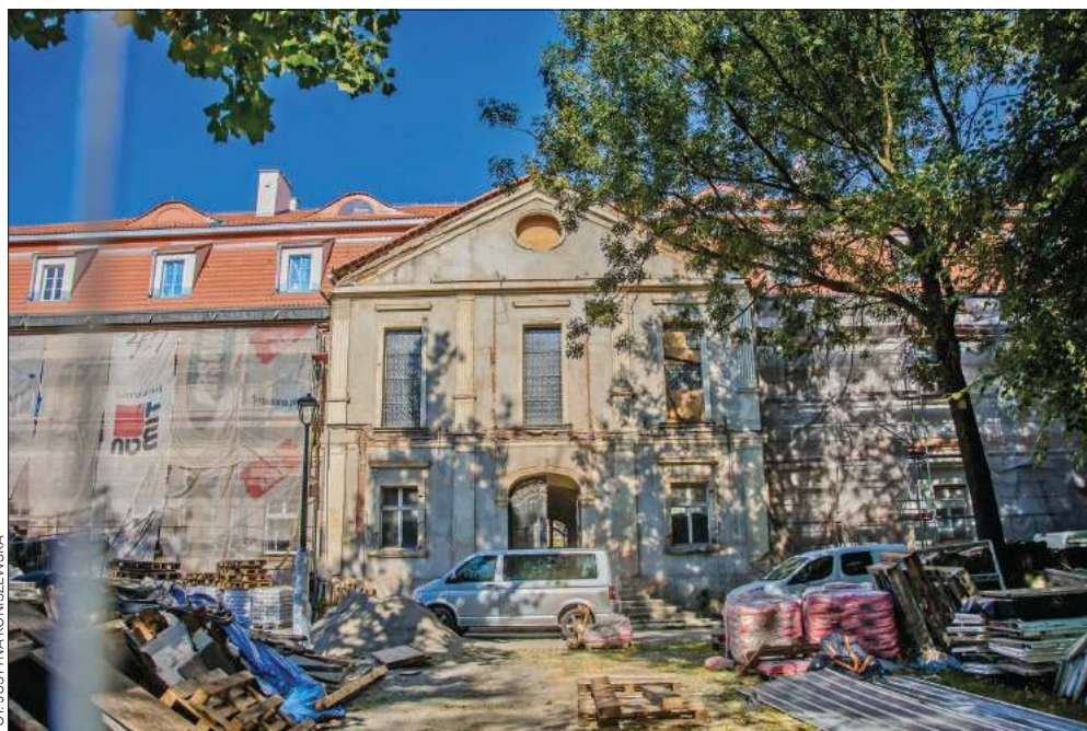
Obecnie są realizowane z kolei takie roboty jak np.: malowanie elewacji północno-zachodnie
