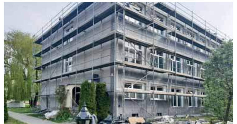
Prace w Zielonej mają być zakończone po wakacjach
