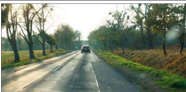
Pierwszy etap budowy ścieżki obejmuje odcinek drogi wojewódzkiej nr 409 od skrzyżowania z drogą dojazdową do Centrum Terapii Nerwic w Mosznej do ul. Leśnej w Zielinie.
