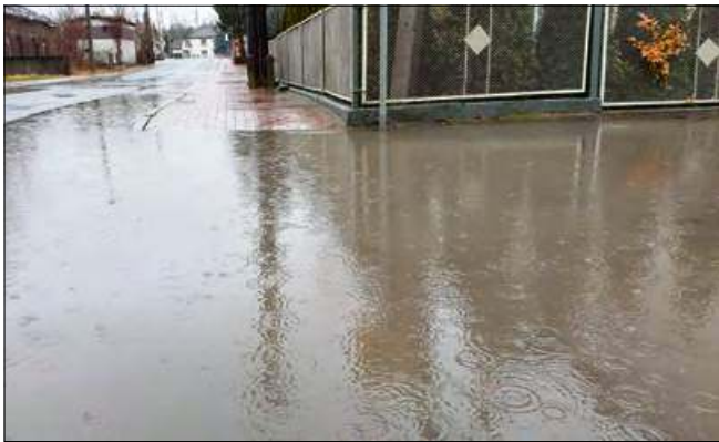
Zalana jezdnia, zalane chodniki...
