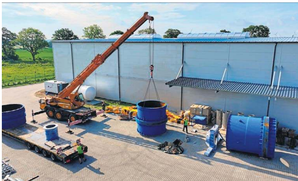
Budowa instalacji przetwarzania odpadów firmy Emka w Redzikowie
