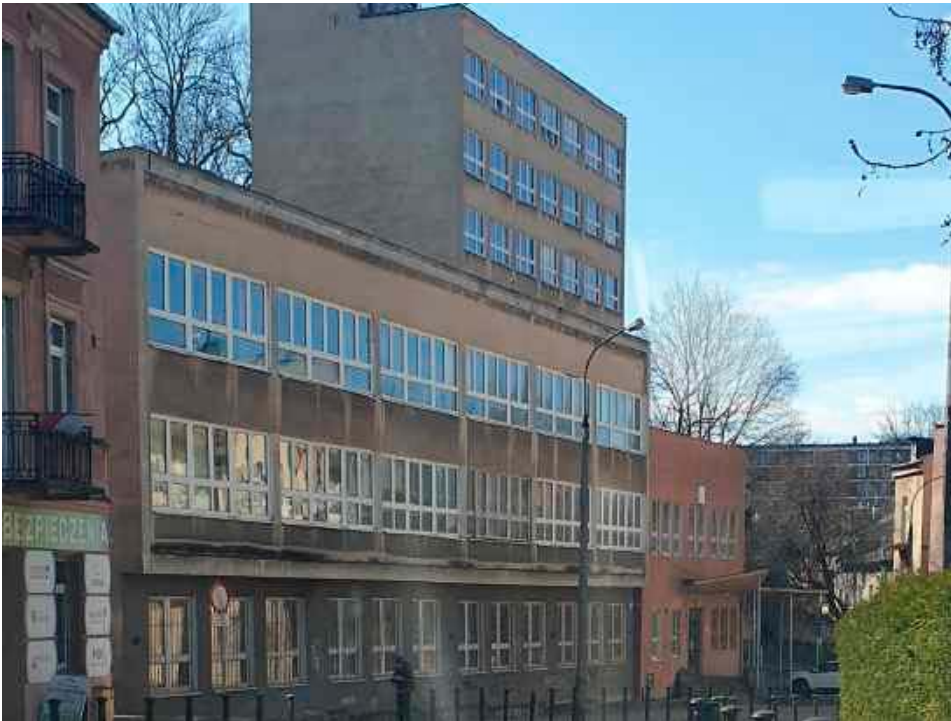
Stary biurowiec przy ul. Leszczyńskiego stoi nietknięty, a zgodnie z założeniami miał być rozebrany przed końcem ubiegłego roku
