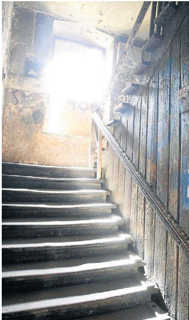
Taka klatka schodowa to dziedzictwo ulicy Kamiennej, które przeszło już do historii
