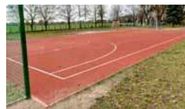
W ramach inwestycji powstało boisko do piłki nożnej i koszykówki
