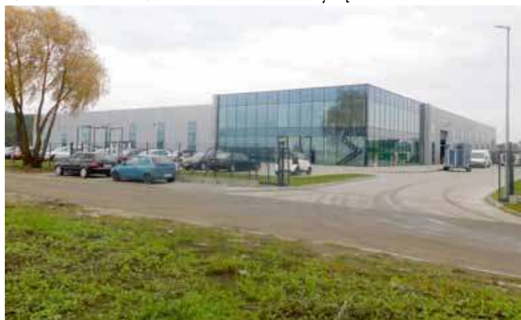
Nowa siedziba firmy Nowo-Glas przy ulicy Górnej mieści i pomieszczenia biurowe i część produkcyjną
