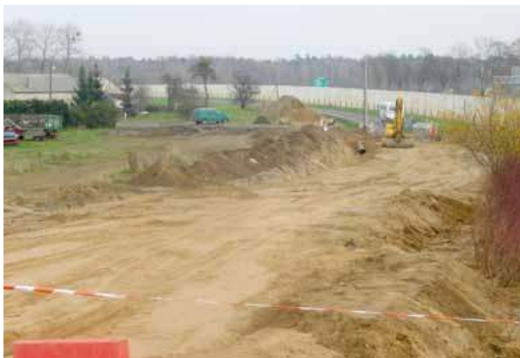
Trwają prace na brakującym odcinku od wiaduktu w Wojcieszynie istniejącej już Drogi Dojazdowej 1 (Żabowo-Wojcieszyn)
