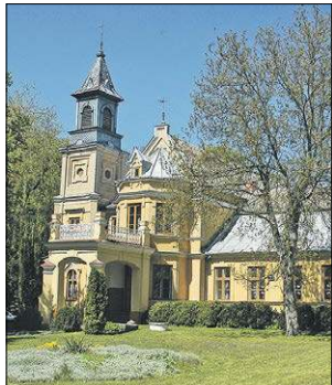
Pałac w Branicy Radzyńskiej stoi niezagospodarowany od 2018 roku
