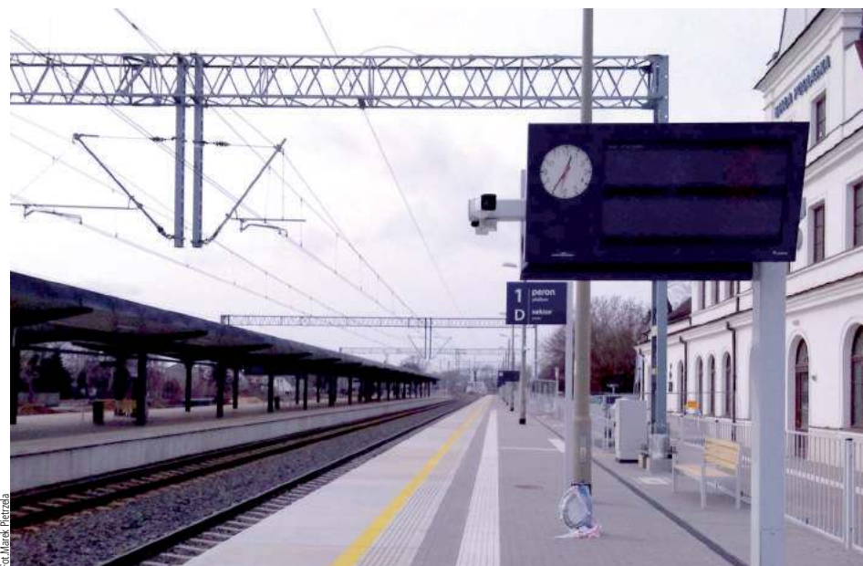
Po oddaniu do użytku peronu nr 1 przy budynku dworca zyskali podróżni na bezpieczeństwie, a stacja na estetyce
