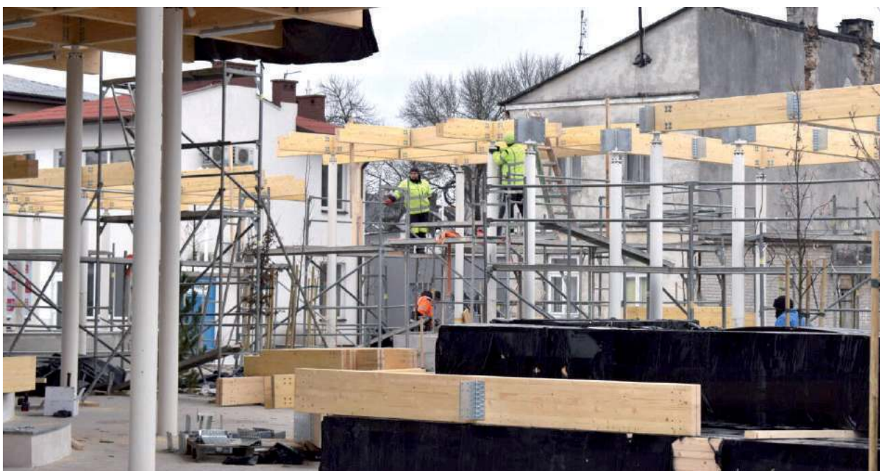
Roboty pierwotnie miały zakończyć się w grudniu, jednak zdecydowano się na dodatkowe wzmocnienia, co wydłużyło nieco termin oddania gotowej inwestycji
