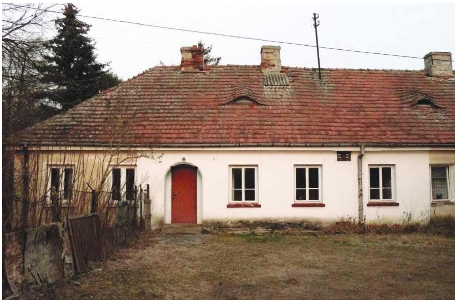
Zabytkowa oficyna przy ruinach pałacu
