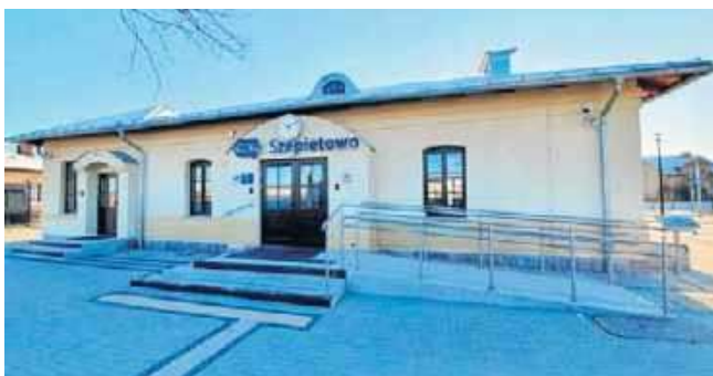
Przebudowa kosztowała 5,4 mln zł. Część kwoty pochodziła z unijnego Programu Operacyjnego Infrastruktura i Środowisko
