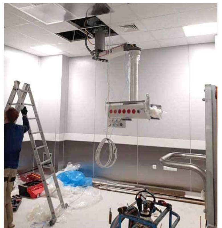
Montaż kolumn chirurgicznych
