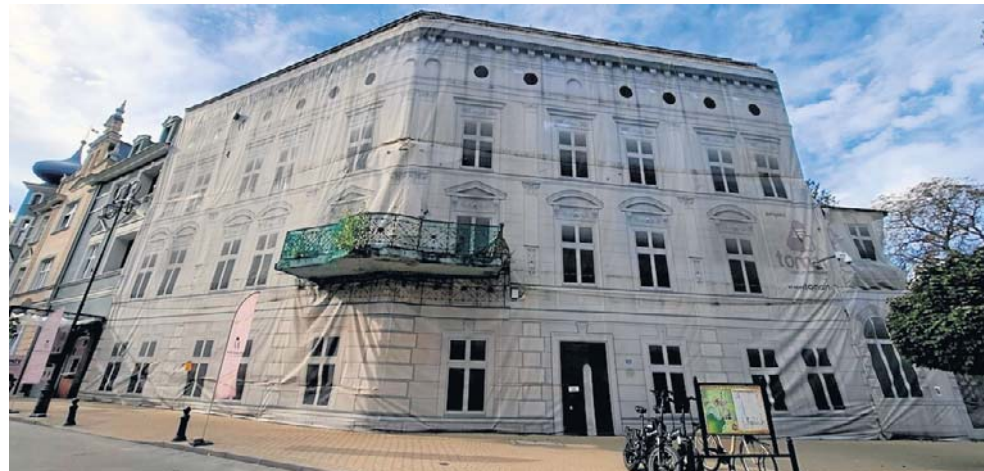
Od kilku lat niszczący budynek jest przysłonięty siatką maskującą, z nadrukiem elewacji. To zasłania ruinę w środku.
