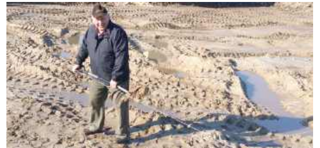
Na zdjęciu sołtys Stanisław Adamowicz. Budowa świetlicy to w dużej mierze jego zasługa
