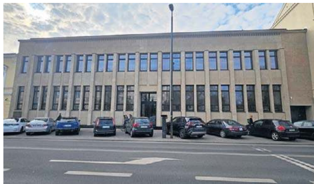
Dwukondygnacyjny budynek biurowo-usługowy został wzniesiony w 1934 r.
