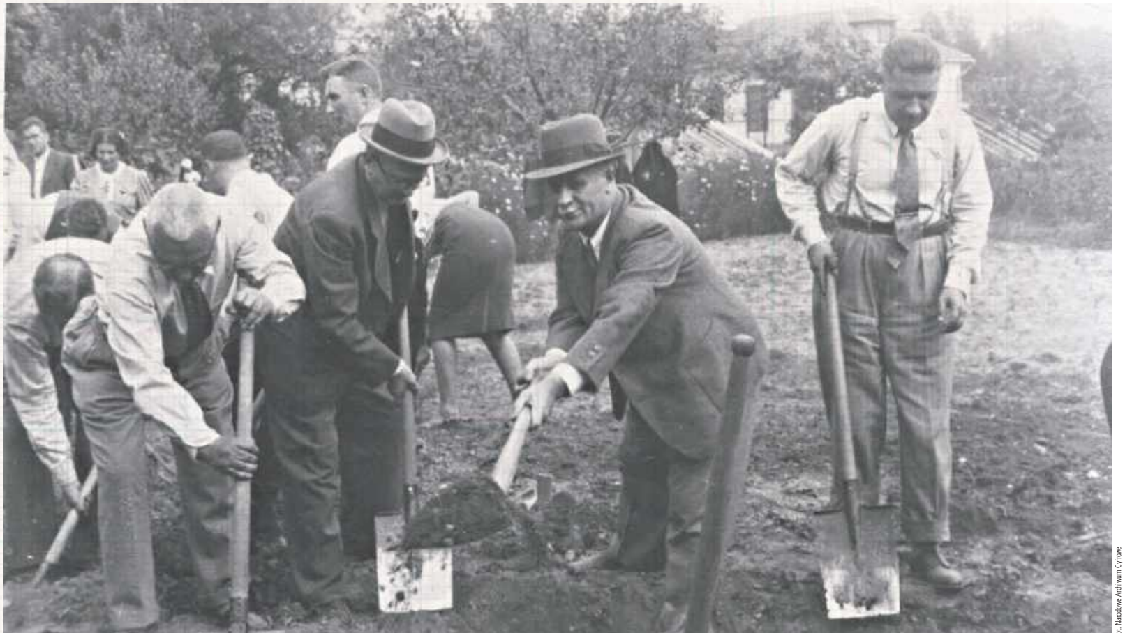
Lublinianie przy kopaniu rowów. Na pierwszym planie widoczny wojewoda lubelski Jerzy Albin de Tramecourt (z prawej), 1939 rok
