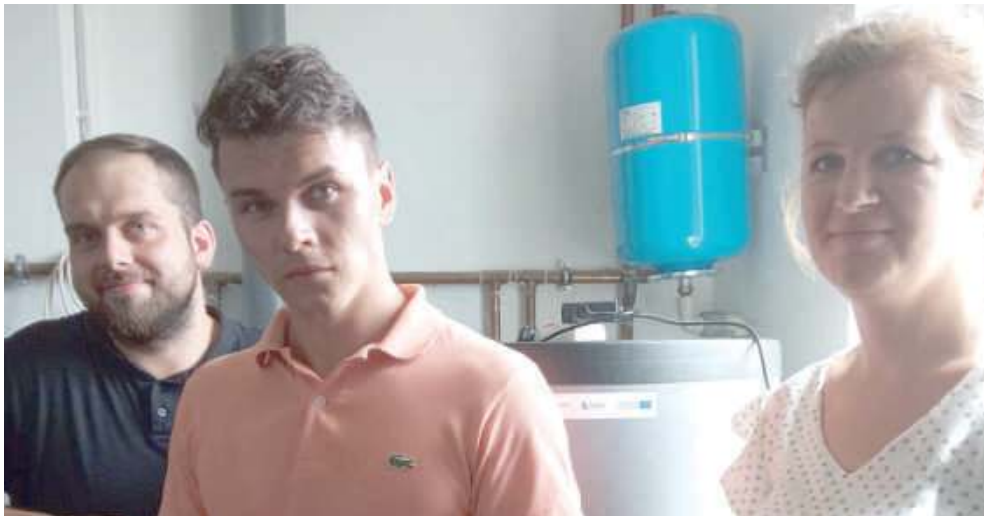
Mieszkańcy mogą już korzystać z kolektorów. w 50 domach zamontowano instalacje 2-kolektorowe (pojemność 200 l), a w 17 – instalacje 3-kolektorowe (pojemność 300 l)
