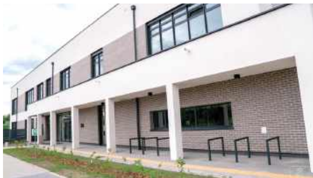
Kompleks został wykonany z dbałością o najwyższe standardy wykonania. Na zdjęciu elewacja i zagospodarowanie zieleni
