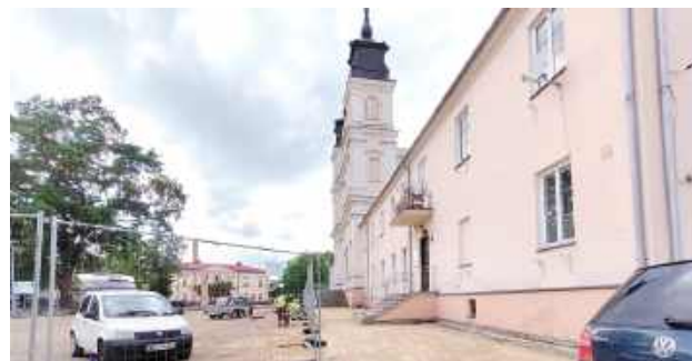
Na początku czerwca na plac budowy wkroczyła również firma podwykonawcza, która odpowiada za wykonanie nowej nawierzchni
