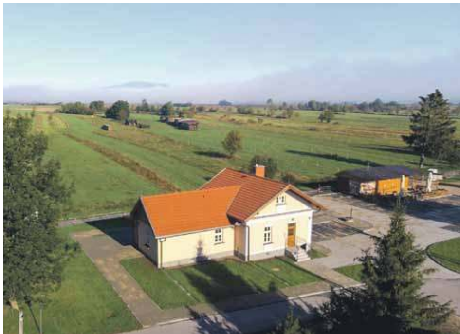
Dawny dworzec kolejowy w Podczerwonym po remoncie.
