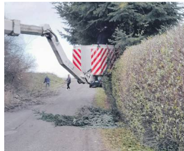
W pracach porządkowych bardzo przydatny był ciężki sprzęt, m.in. podnośnik kosowy. Fot. Sołectwo Zarzycy
