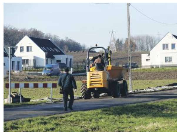
Niedawno ruszyły prace związane z przebudową ul. Siemysławickiej w Przewornie
