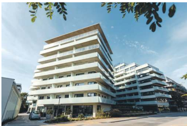
Apartamenty Central Park Wrocław wybudowane przez Gradi Invest
