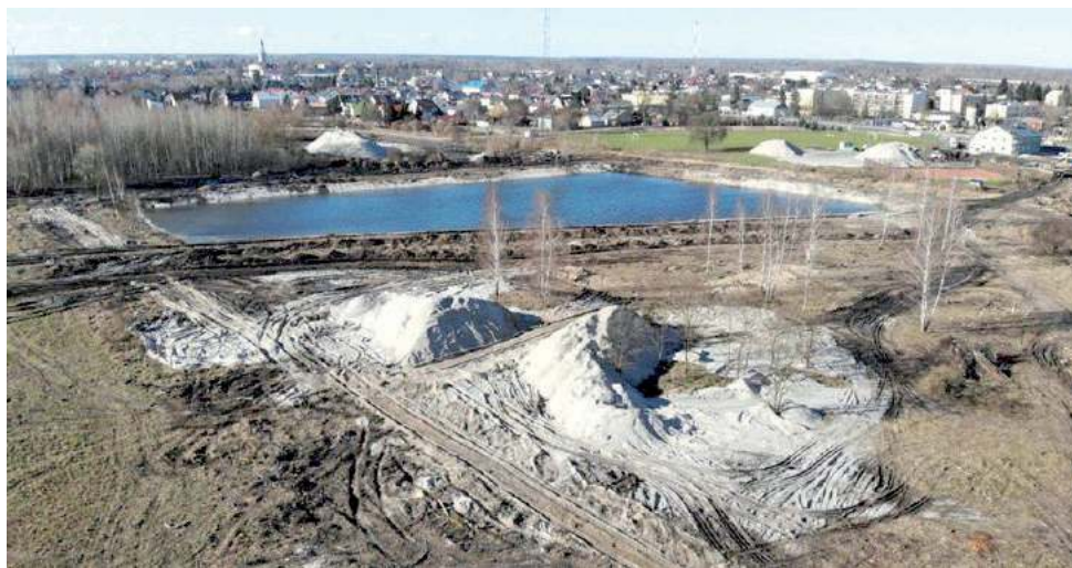
Prace przy rewitalizacji terenu Konowicy idą pełną parą. Warunki atmosferyczne sprzyjają. Czy teren przyciągnie nowych mieszkańców?
