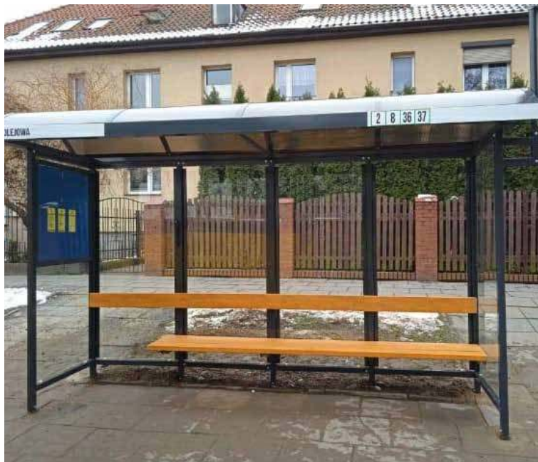
Na przystanku Lotników – Kolejowa pojawiło się nowe zadaszenie
