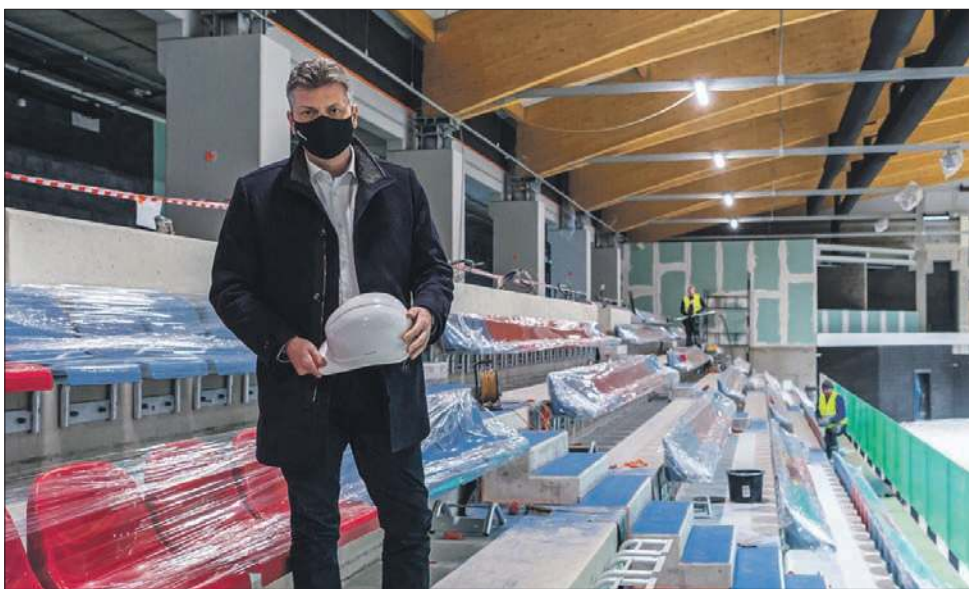
Prezydent Bytomia zadowolony z jakości i tempa prac na budowie lodowiska
