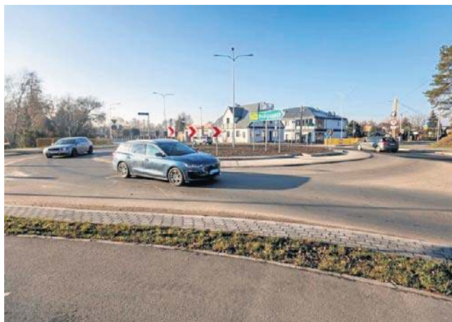
Tak prezentuje się rondo w podbydgoskiej Brzozie na drodze wojewódzkiej nr 254. Drogę przebudowano na 22-kilometrowym odcinku do Barcina
