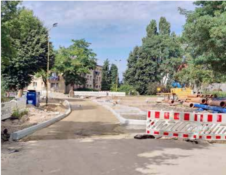
Stan prac w obrębie skrzyżowania w czwartek rano
