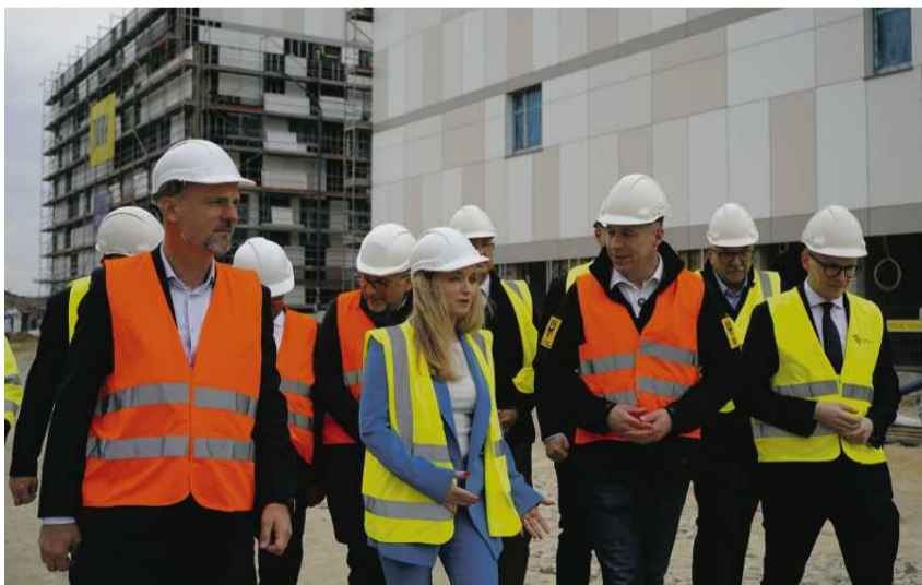
Marcowa wizyta na budowie szpitala. Na zdjęciu m.in. Minister Zdrowia Jolanta Sobierańska-Grenda oraz Marszałek Woj. Dolnośląskiego Paweł Gancarz, fot. materiały prasowe UMWD
