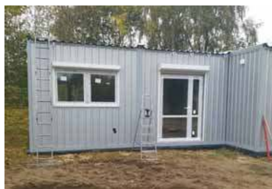
Niedawno zakończono budowę świetlicy kontenerowej w Pawłótku
