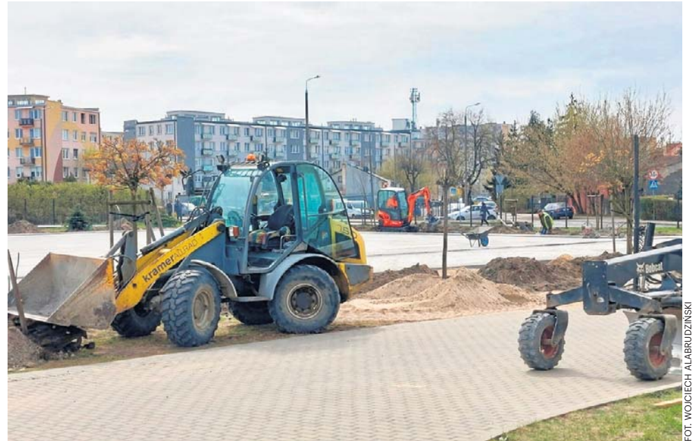
Przy SP nr 12 trwa budowa boiska piłkarskiego z bieżnią lekkoatletyczną
