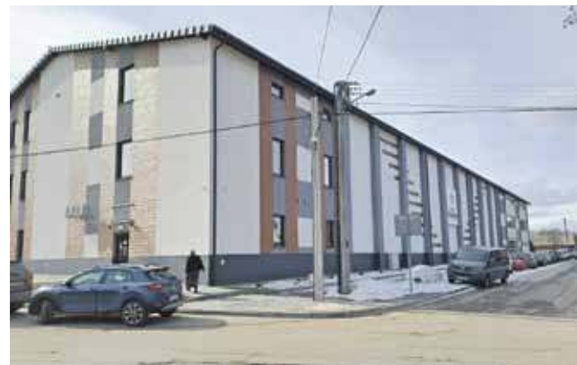
Nowa hala w Szaflarach kosztowała 11 mln złotych.
