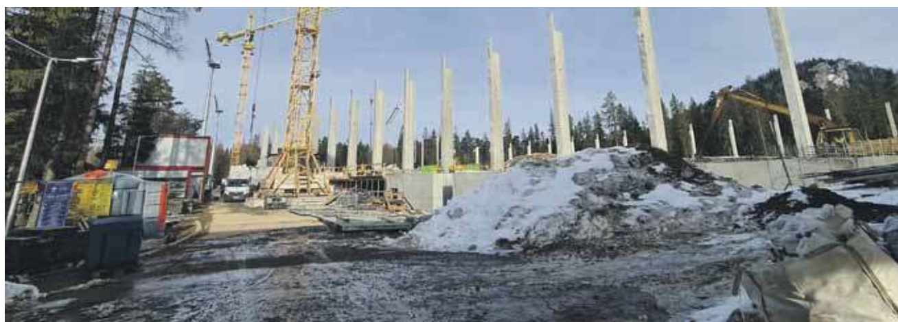
Tak dziś wygląda budowa krytego toru lodowego, na którym mogłyby odbywać się olimpijskie zawody w łyżwiarstwie szybkim.
