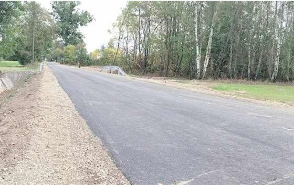
Aż miło popatrzeć na nowy asfalt
