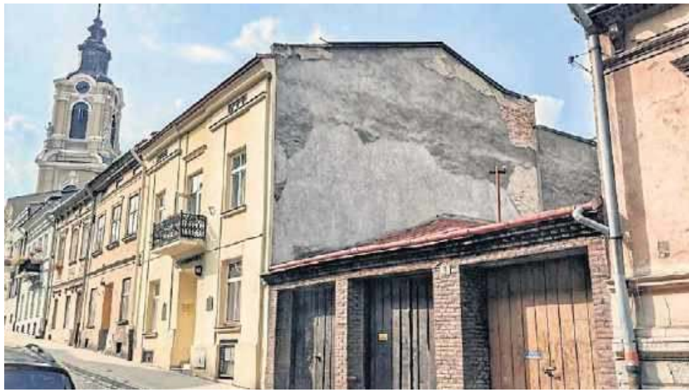
Obecny wygląd budynków dawnej firmy Witolda Trandy, przy ul. Katedralnej w Przemyślu
