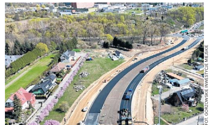
Budowana właśnie ulica Kamienna została już połączona z rondem Barlineckim
