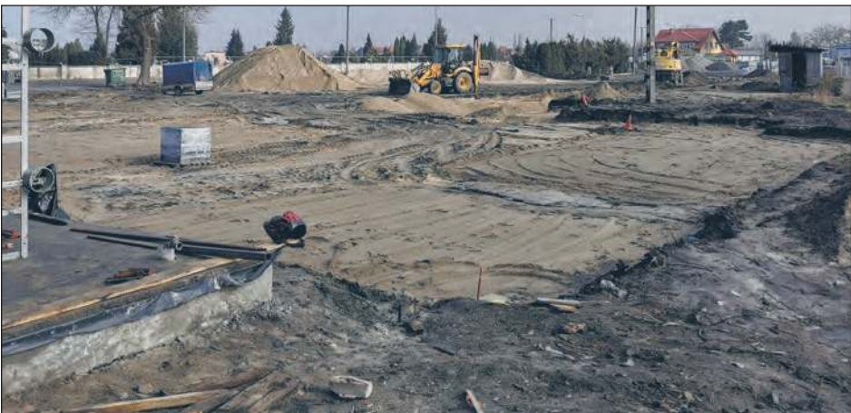
W marcu ruszyły prace nad utwardzeniem nowego placu targowego. Budowa nowego targowiska będzie kosztować blisko 1,7 mln zł. Znajdzie się na nim 109 miejsc do handlu
