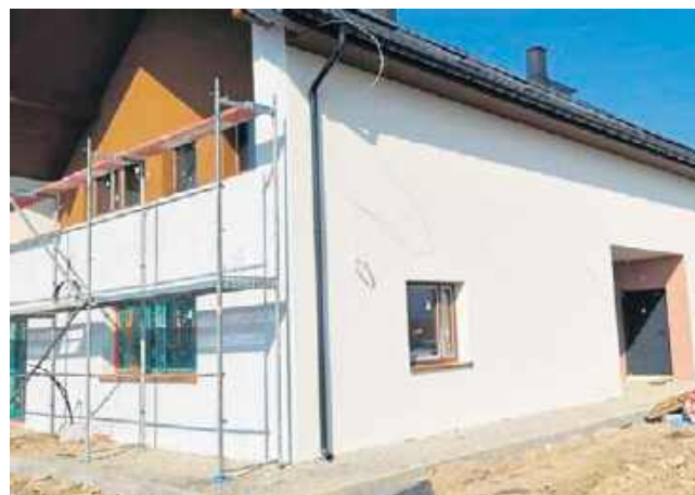
Trwają prace wykończeniowe wewnątrz, a także na zewnątrz domu wraz z zagospodarowaniem terenu
