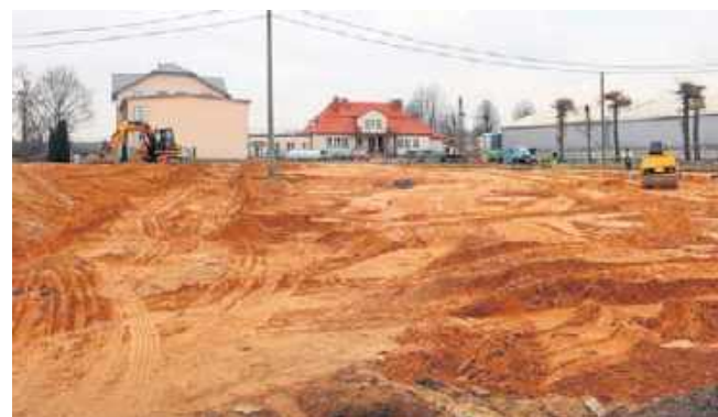
Trwa budowa kompleksu sportowego w Rudzie Strawczyńskiej w gminie Strawczyn
