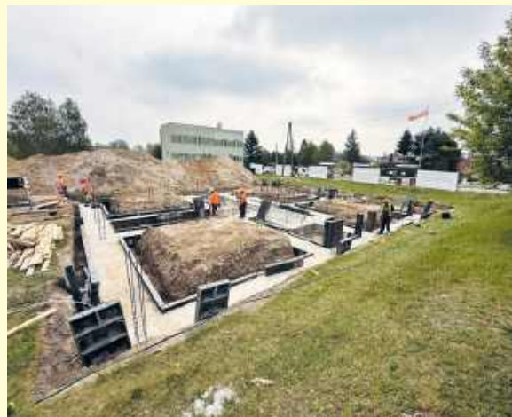
Zakończył się już etap prac ziemnych. Widać pierwsze efekty działań prowadzonych przez budowniczych.
