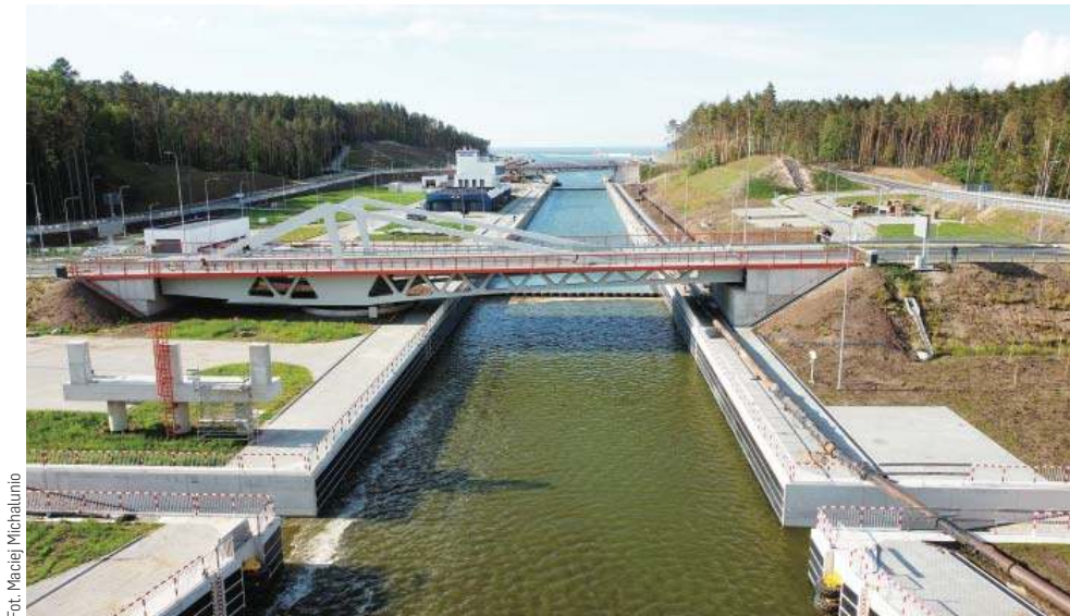
Mierzeja Wiśłana. Czerwiec 2022 na terenie budowy przekopu
