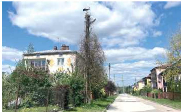
Bociany wybrały sobie na gniazdo słup energetyczny przy ulicy Północnej w Biłgoraju. Mieszkańcy twierdzą, że to bardzo niebezpieczne dla ptaków
