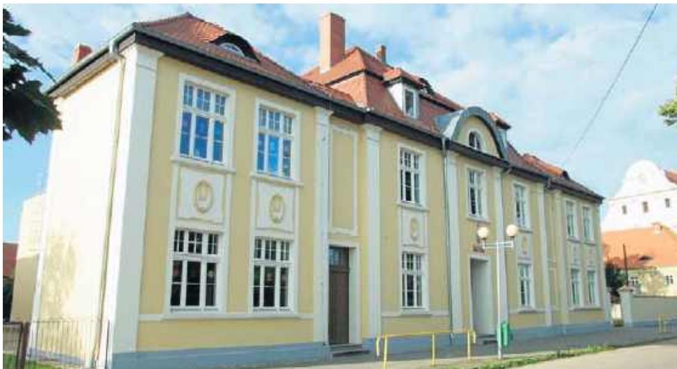
Modernizacja budynku ZOL w Wągrowcu dobiega końca.
