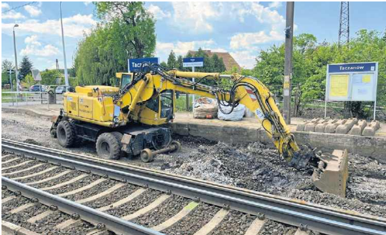
Po dworcu PKP pora na remont torowiska.
