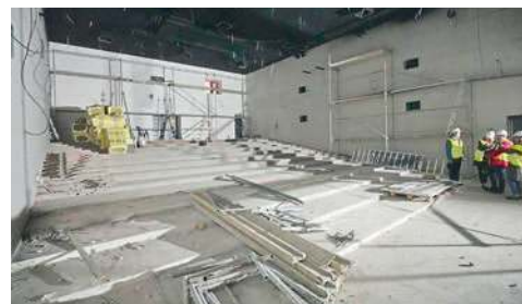
Sala kinowa w remoncie
