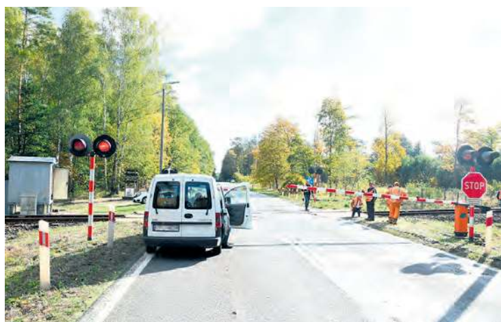
Przejazd kolejowy na drodze Tuchola-Świecie, niedaleko Błędzimia, tuż przed Rykowskiem.
