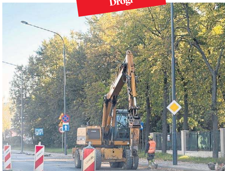
Na remontowanym odcinku w poniedziałek (29 września) o godz. 8.30 pracowało ok. 7 robotników.
