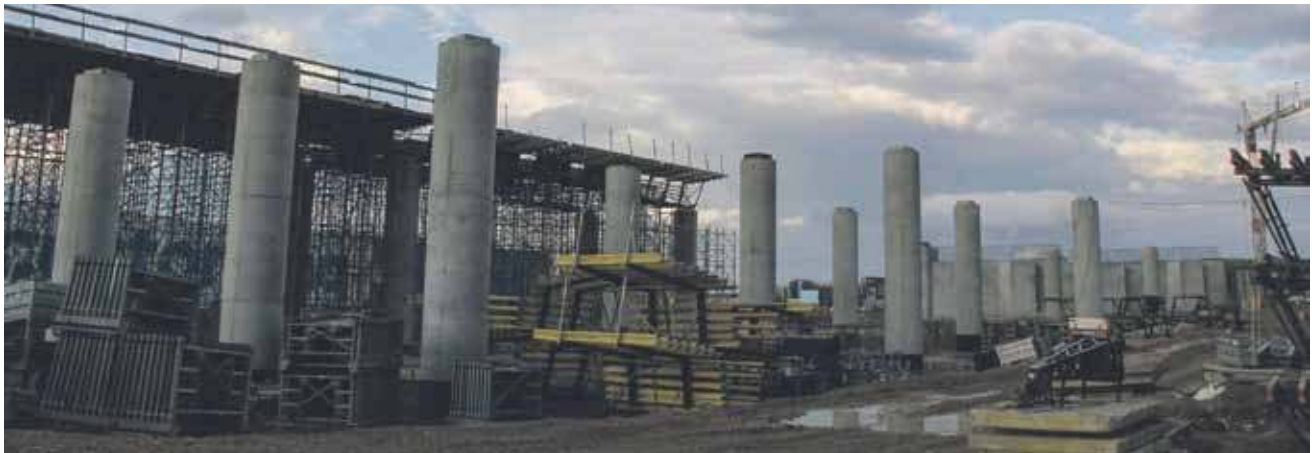
Węzeł Nowy Targ Południe dopiero powstaje. To tu początek będzie miała obwodnica wiodąca prosto w stronę Bukowiny Tatrzańskiej czy Szczawnicy.
