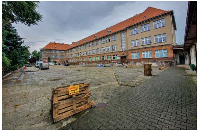
Remontowana Szkoła Podstawowa nr 95 przy ul. Starogajowej
