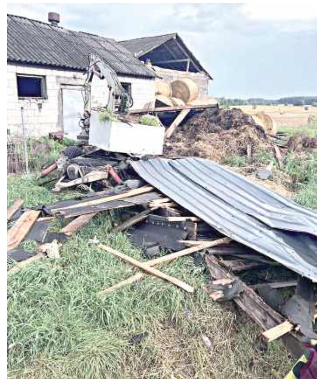
Najwięcej pracy strażacy mieli przy zabezpieczaniu budynków uszkodzonych przez silne podmuchy wiatru
