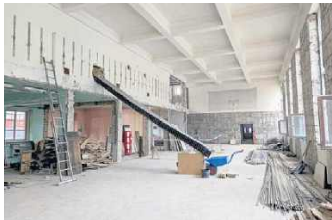
Prace prowadzone są wewnątrz budynku. Najpierw trzeba dokonać rozbiórki, by można było zacząć remont
