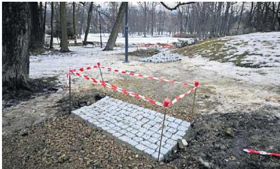
Wodospusty wykonane z kostki granitowej mają skuteczniej odprowadzać wodę
