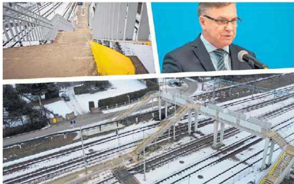
Skandal na dworcu kolejowym w Libiążu. Zniknęła płoza z kładki. Gmina żąda budowy tunelu
