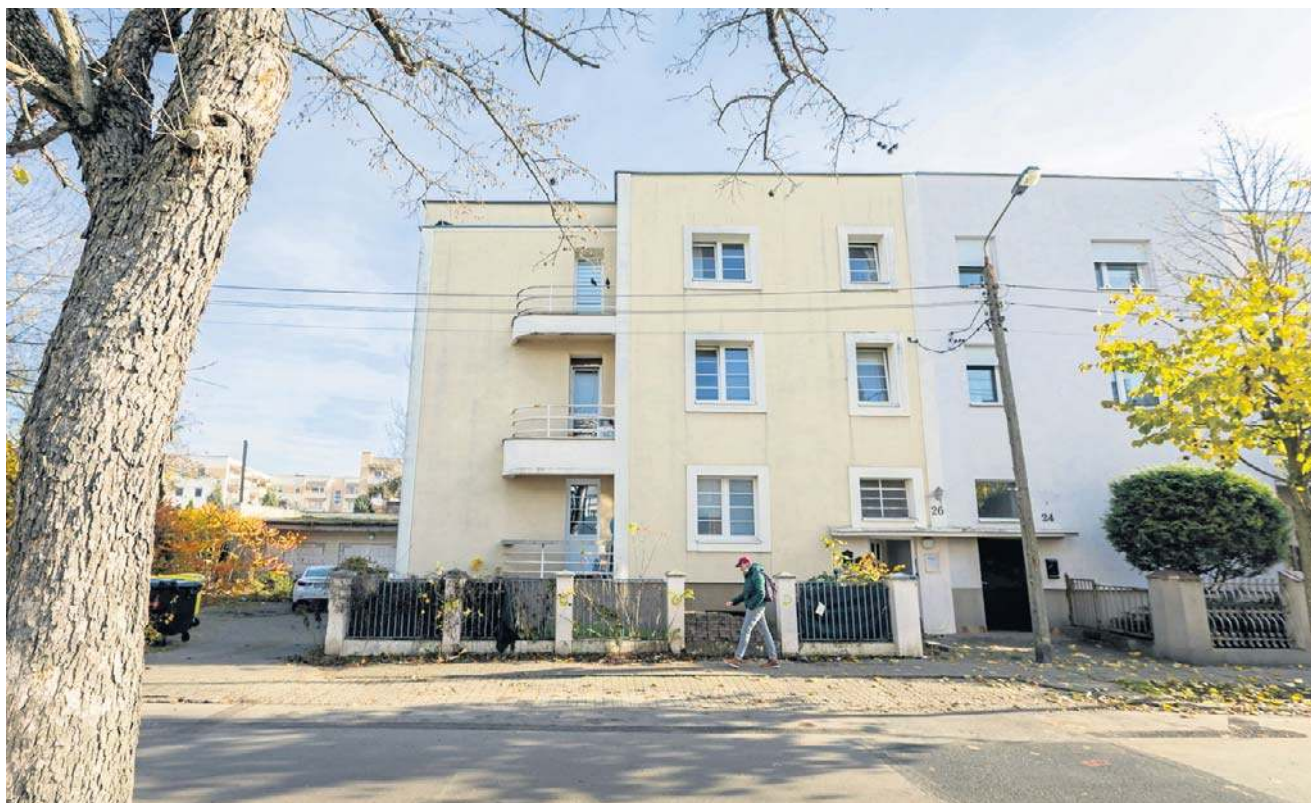
Stały dopływ wody w kamienicy z powodu awarii wyłączono w sierpniu
